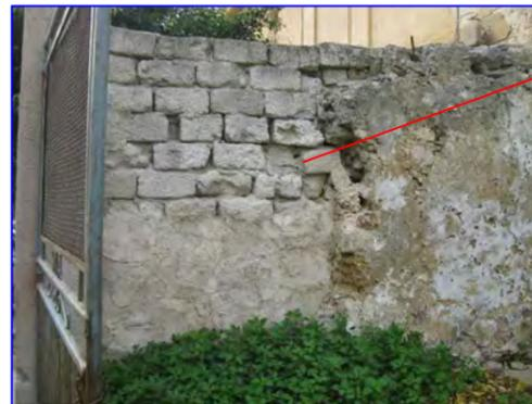
sistemazione delle pareti laterali in muratura nelle due facce mediante rinvenimento delle parti in pietra ed allineamento dell'esistente, regolarizzazione e listatura delle pareti
